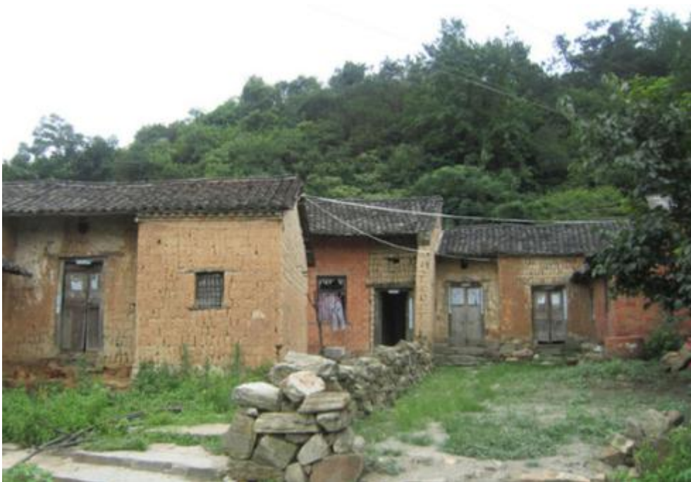
C级土坯、砌体结构
